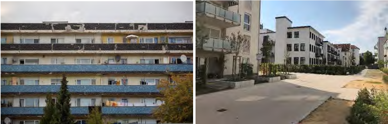
Abbildung 69: Sanierungsbedürftiges Wohngebäude und Neubau "Heimathafen" (Bildquelle: ProjektStadt)
