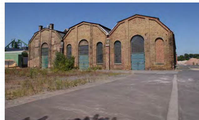
120. Dreibogenhalle (Foto: AS&P GmbH)
