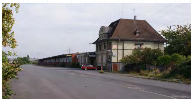
129. Langgestreckte Lagerhalle (Foto: AS&P GmbH)
