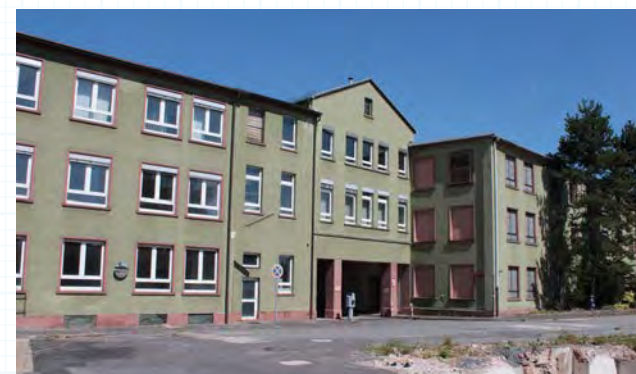
119. Verwaltungsgebäude Mainstraße (Foto: AS&P GmbH)
